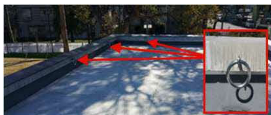
丸環（トイレ屋上）
